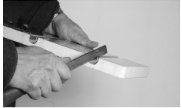
Katkaisun jälkeen urien reunat puhdistetaan viilalla, jotta lattialämmitysputket eivät vaurioituisi.
