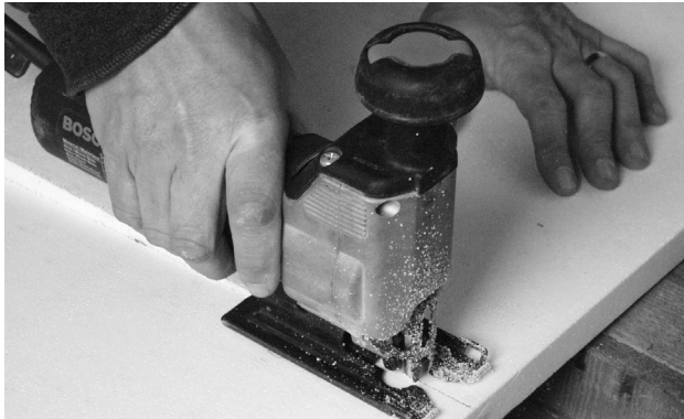
Compact®-levyt katkaistaan pistosahalla. Levyt sahataan kääntöpuolelta.
